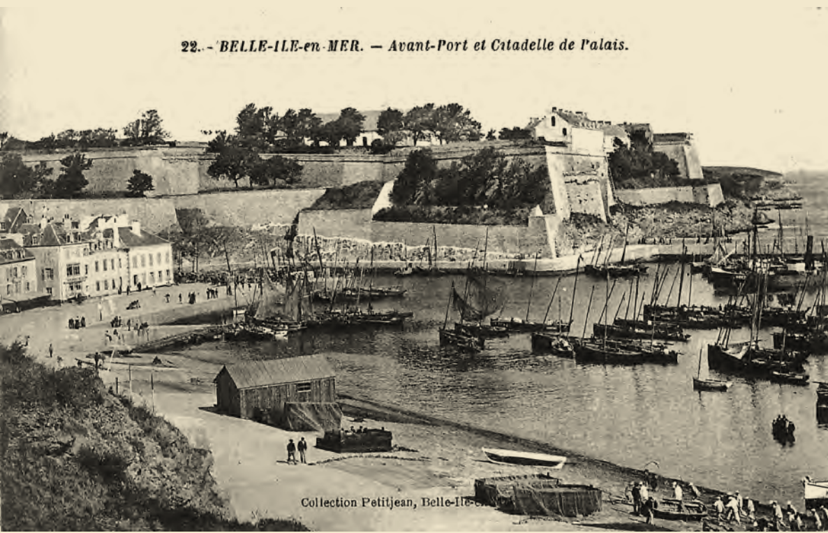
Vue du port depuis la Montagne après la construction de l'avant-port.
