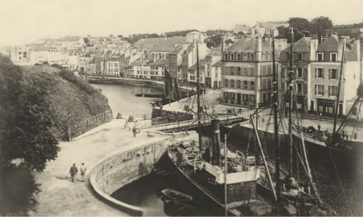
Le pont tournant en bois construit vers 1845 a été utilisé pendant près d'un siècle.
